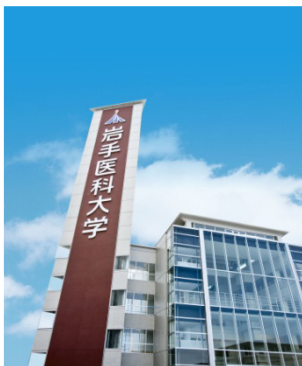
平成23年度2月竣工の新校舎
